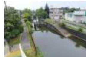
葛西用水は元荒川と合流してきれいな水を農業用水に送っていましたが、カスリーン台風(1947)以後の抜本的な「水害対策」として、埼玉県では昭和35年から約7年間を要して、元荒川の下を伏越樋管(ふせごしひかん)でくぐらせる、いわゆる川の立体交差工事を行いました。
