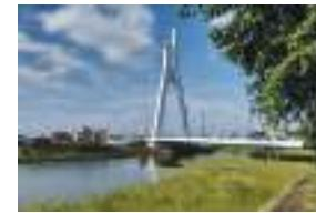
県道八潮越谷線の元荒川と葛西用水に架かる橋。白い大きな主塔から斜めに張ったケーブルで橋を支える市内唯一の斜張橋です。その姿は、翼を広げて寄り添い、大空に向かって飛び立つ2羽のシラコバトをモチーフにしています。夜間はライトアップされます。平成6年(1994)開通、橋長145.1m、幅員13.0m、高さ51m。
