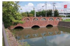
流通団地の中央から入る市道80077号線の東京葛西用水と谷古田用水に架かる橋。レンガ張りのモダンな橋は、アーチ形が水面に映り眼鏡のように見える。コンクリート製品(アーチ型ボックスカルバート)を組み合わせて造られた。(20ページ参照)
