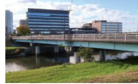
葛西用水に架かる平和橋とつながり、一つの橋のような印象を受けるが別の橋。昭和36年から始まった元荒川と葛西用水の分離工事に際し、川に対し斜めに渡すという難しい工事であった。(13ページ参照)
