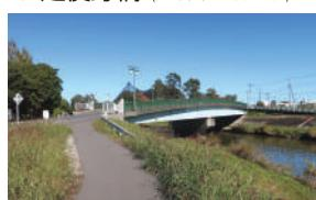
旧県道越谷野田線の橋で、現在は市道になっている。葛西用水と新方川が伏越(ふせこし)という工法で立体交差する珍しい光景が見られる。現在の橋の架け替え工事に合わせて隣接地に定使野公園が整備された。(6ページ参照)
