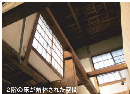
2階の床が解体された空間
