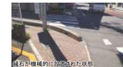
縁石が機械的に設置された状態
